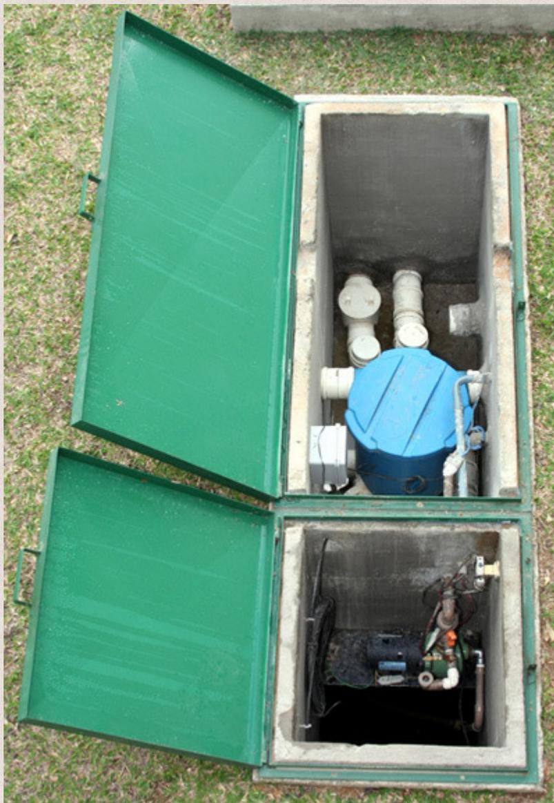
Vista interna da cisterna identificando-se o dispositivo de descarte de sólido e a motobomba.
